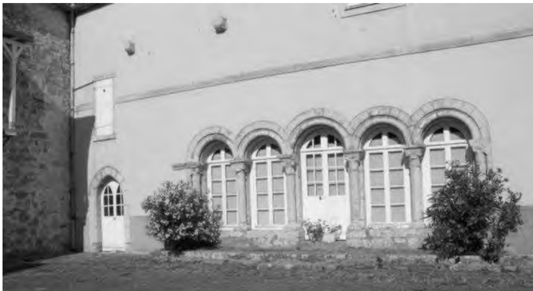
Ouvertures de la salle capitulaire. Remarquer, en haut, les corbeaux de pierre qui soutenaient la sablière haute de la galerie du cloître.
