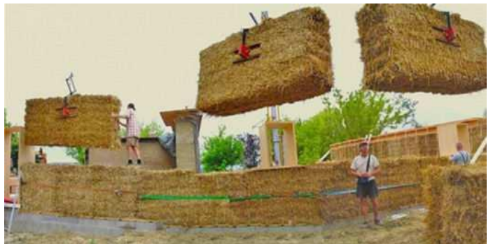
Construction d'une maison en paille
